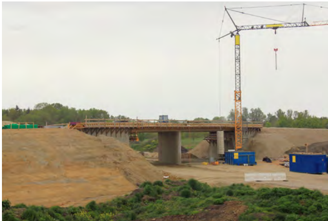
Abb. 01: Neu erstelltes Brückenbauwerk
