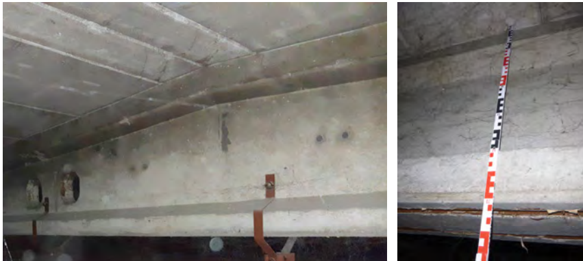
Abb. 03: Tatsächliche Ausführung des Binders in Stahl- bzw. Spannbetonbauweise [Quelle: bau-ray GmbH]
