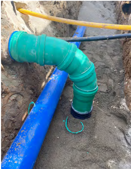
Abb. 01: Abschnitt eines neu hergestellten Leitungsstrangs für die Trinkwasserversorgung (blaue Rohrleitung)
