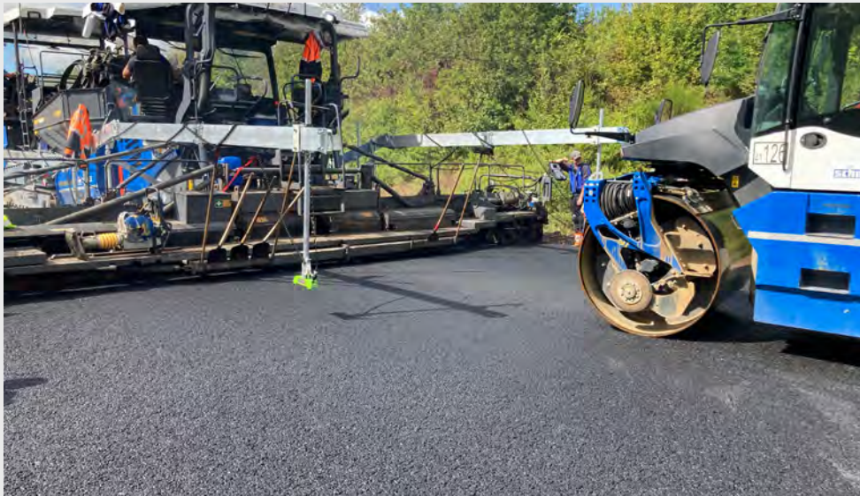
Abb. 02: Herstellung eines temperaturabgesenkten Asphalts mit Absaugeinrichtung am Straßenfertiger [Quelle: Autobahn GmbH]
