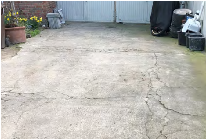
Abb. 01: Der zu unterquerende Bereich vor dem Mehrfamilienhaus
