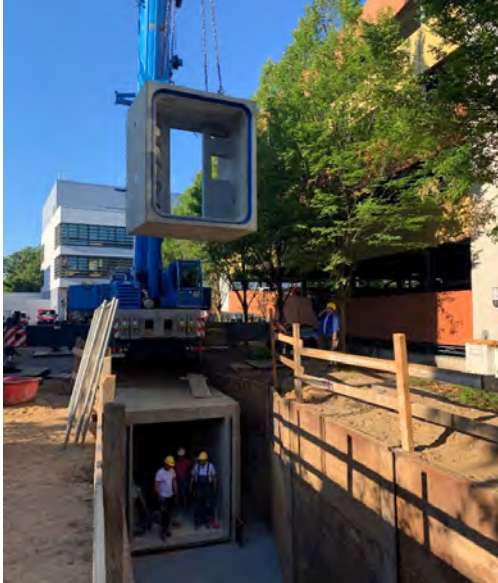
Abb. 01: Innerstädtischer Neubau eines begehbaren Leitungskanals [Foto: GIBA mbH]
