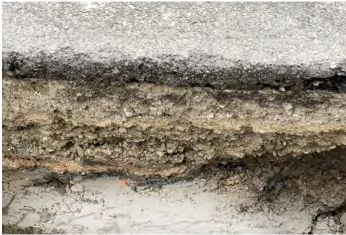
Abb. 02: Gipslinse im Baugrund
