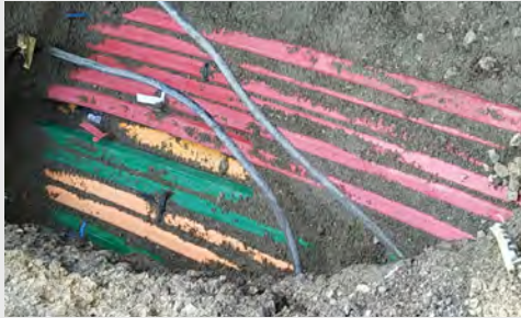
Abb. 04: Überbaute Stromtrasse in der Praxis [Quelle: Netze BW GmbH]
