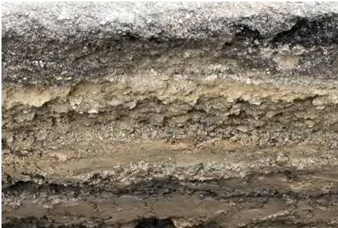
Abb. 03: Ungestörter Boden im Bereich der Baugrunduntersuchung
