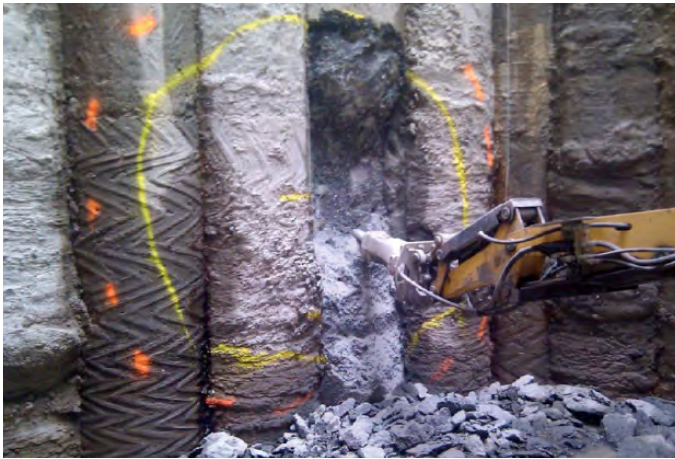
Abb. 01: Öffnung der Bohrpfahl-/Baugrubenwand durch einen Bagger mit Hydraulikhammer
