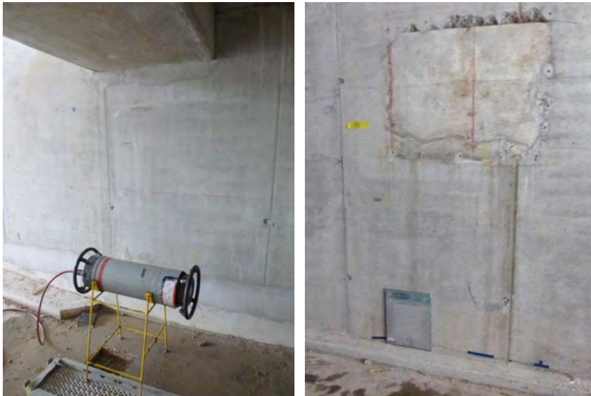
Abb. 10: Prüfaufbau mit Röntgenröhre (links) und Detektor (Speicherfolie, rechts) [Quelle: bauray GmbH]
