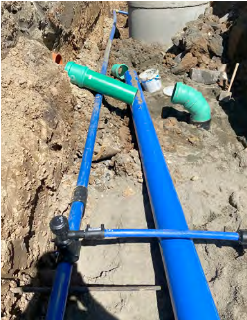
Abb. 02: Abschnitt eines neu hergestellten Leitungsstrangs für die Trinkwasserversorgung, Zwischenstand während des Hygienetests
