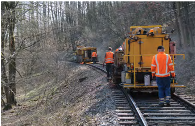
Abb. 02: Testfeldertüchtigung – Schleifen der Gleise durch die Alberts Fischer GmbH [Foto: Thorsten Försterling]
