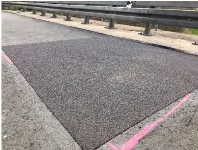
Abb. 01: Beispiel einer Brandschadensanierung an der A 14 [Quelle: Triflex]
