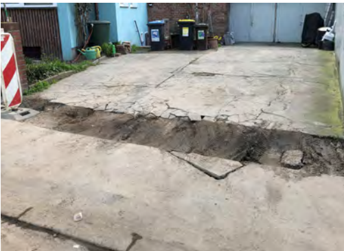
Abb. 03: Unterspülung im Bereich des Gehwegs und der Garagenzufahrt, Zustand nach der provisorischen Verfüllung
